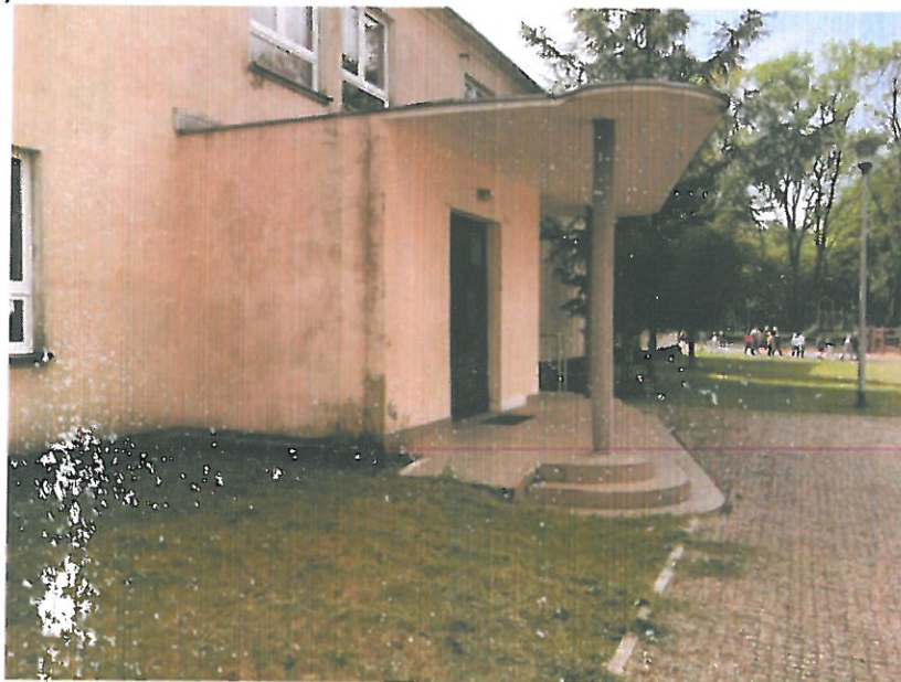
pawilon przeznaczony do rozbiórki
