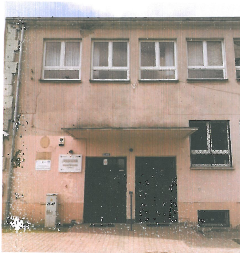
daszek wejściowy przeznaczony do rozbiórki
